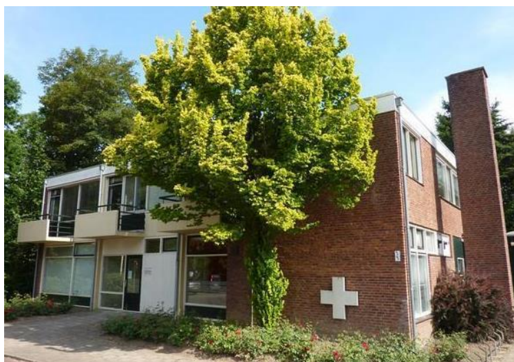
Figuur 6.5: aanzicht vanaf de Prinses Margrietstraat
